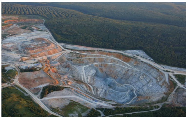
Рисунок 3 - Отработанное Воронцовское золоторудно-известняковое месторождение, Северный участок (г. Краснотурьинск, Свердловская область)
