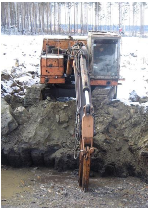
Рисунок 5 - Разработка грунта в водонасыщенных слоях
