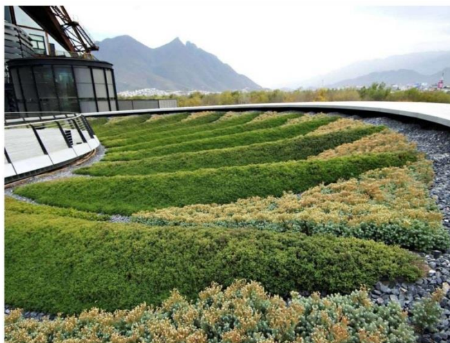
Рисунок 6 – Пример озеленения кровли мхами и суккулентами (Google photos)
