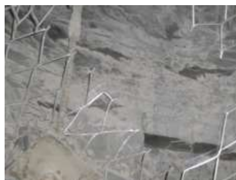
г - вывалы пород из боков выработки
