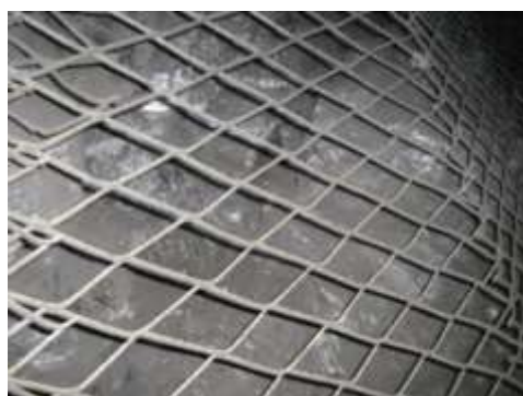
в - нестабильные бока выработки (отжим и выдавливание)
