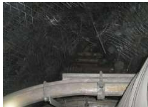
б - куполообразование в кровле выработки при комбинированной крепи
