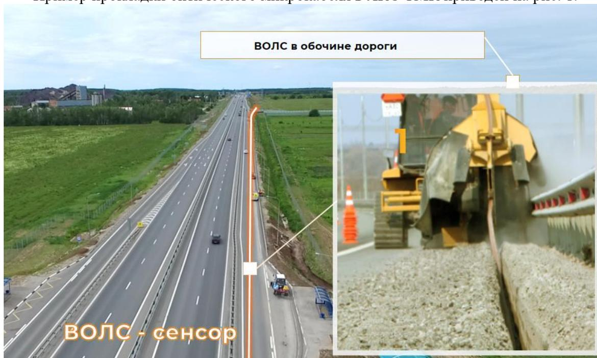
Рис. 1. Пример прокладки оптического микрокабеля в ЛКС ТМК в обочине автодороги.
