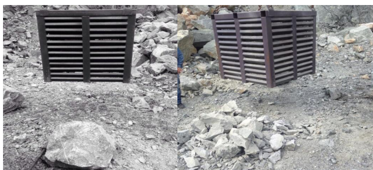
Рис. 3 - Локализатор, до и после взрыва
