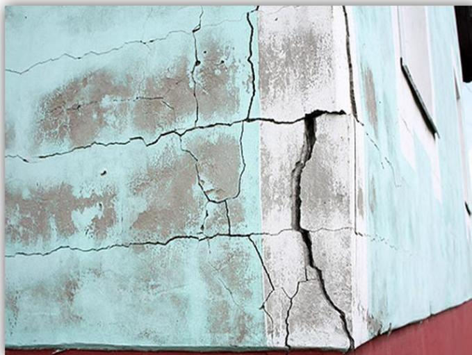
Рисунок 1 –Зияющие трещины блоков
