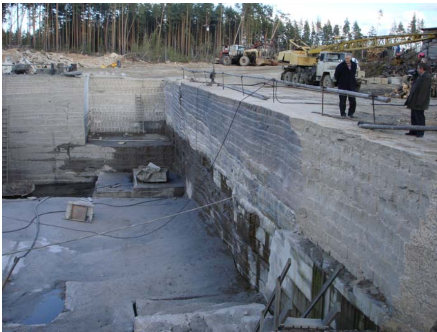
Вскрытие и разработка гранитного карьера «Сосновый бор» с применением алмазоканатных камнерезных машин
