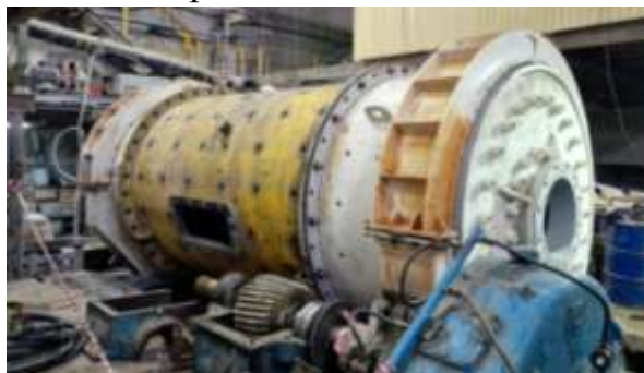
Рис. 3. Монтаж модернизированной мельницы Crutim МШР-2100х5000
