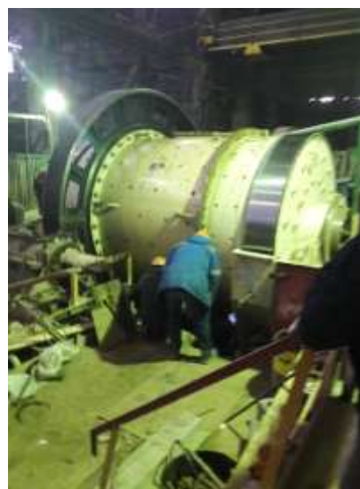
Рис. 2. Монтаж мельницы Crumin МШР-2100х4000
