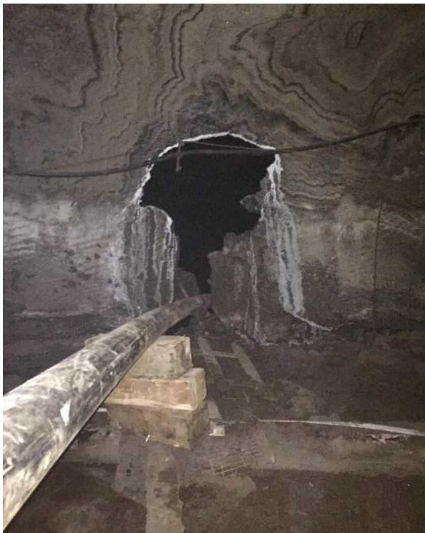
Рисунок 110 – Сквозное отверстие в гидроизолирующем целике – результат неконтролируемого растворения рассолами (по данным автора)
